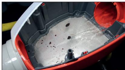
Die Verschmutzungen werden mit überschüssigem Regenwasser in den Kanal abgespült.
